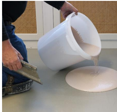
Pour CLL mixture onto prepared surface.
